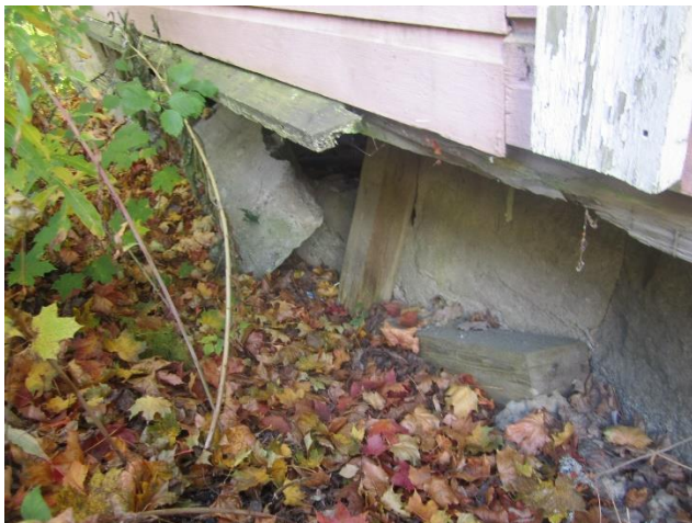
Kuva 2. Sokkeleiden murtumaa
