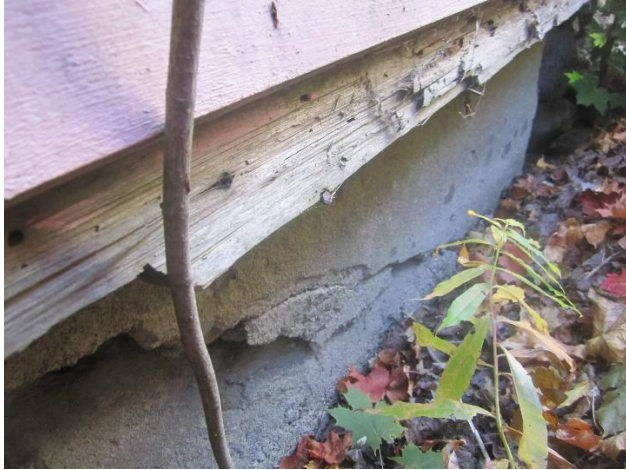
Kuva 1. Sokkelit ovat murtuneet
