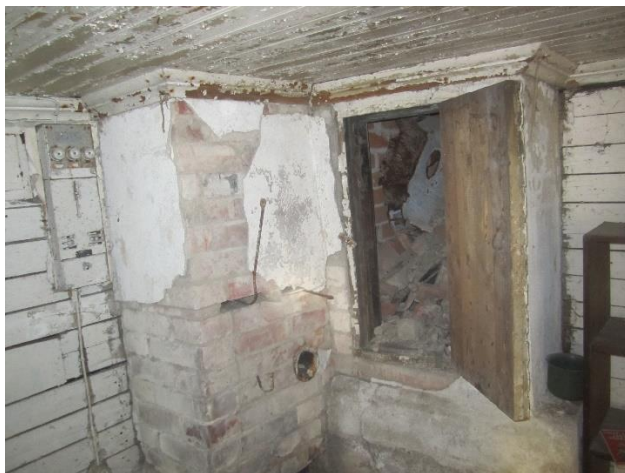
Kuva 4. Kellarikerroksessa on myös piipun perustukset
